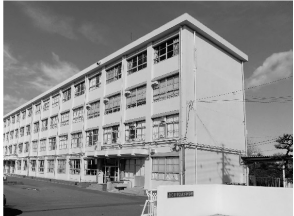
【正門からの坂下中学校外観】
